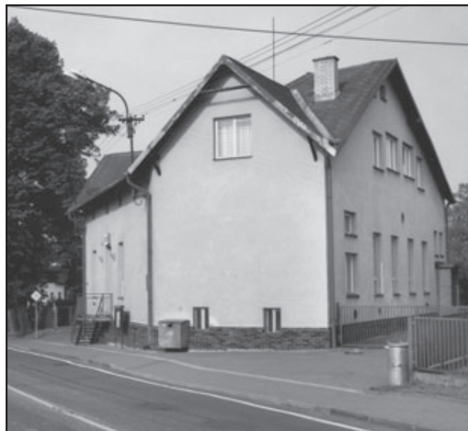
▲ Po rekonstrukcji, widok od strony północno-wschodniej.
