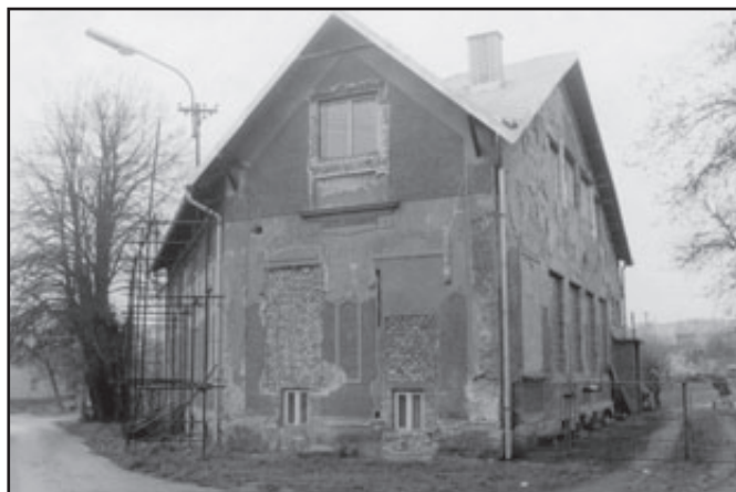
▲ Budynek w trakcie rekonstrukcji.
