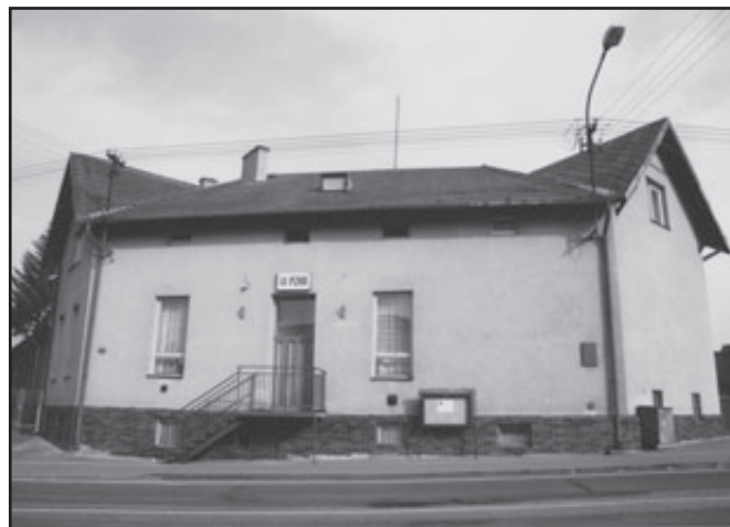
▲ Po rekonstrukcji, widok od strony wschodniej.
