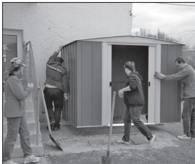
▲ Nasi rodzice przy budowie małego laboratorium ekologicznego.
