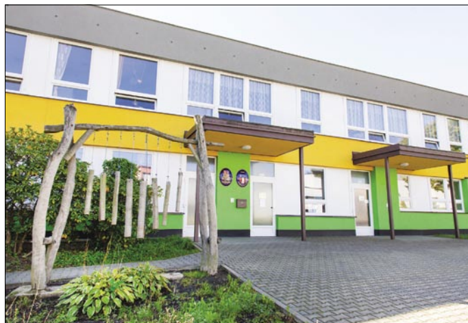
Fasáda mateřské školy s novým nátěrem.
