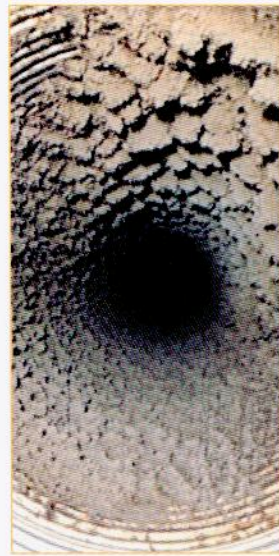
Zanesená kominová vložka pro spotřebič na zemní plyn.
