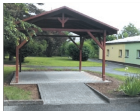
V zahradě Domu s pečovatelskou službou byla dokončena pergola. Ing. CIUPOVÁ, tajemnice
