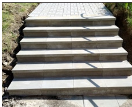
Na základě podaných žádostí nájemníků bytových domů na ul. Středová probíhají opravy některých přístupových chodníků. Další poškozené chodníky budou opraveny v příštím roce.
